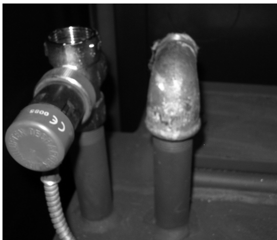
Abb. 3: Thermische Ablaufsicherung, Montage im Kessel
