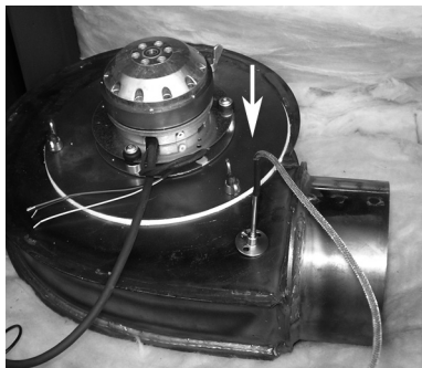
Abb. 25: Der Abgasfühler
