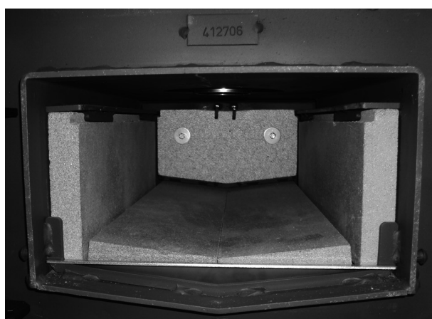
Abb. 29: Aschekasten hinten in der Brennkammer
