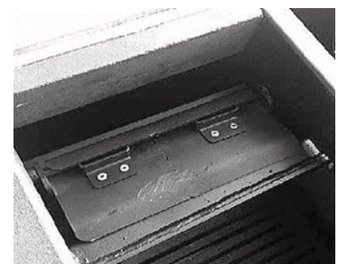
Rauchrichter (17) geöffnet ⇒ die Kesselleistung wird deutlich reduziert
