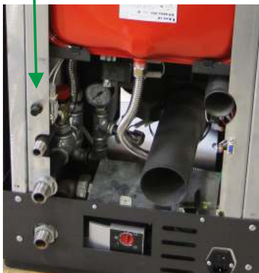
1 – Sicherheitsthermostat (STB)
