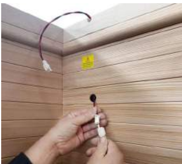
(9) Pripojte svetelný kábel sauny, ako je uvedené vyššie.
